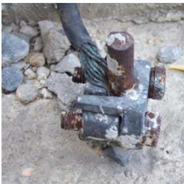
รูปที่ 10 การต่อสายต่อหลักดินเข้ากับดินด้วยแคลมป์
