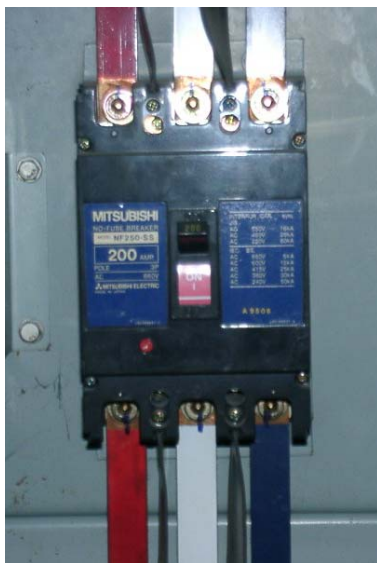
รูปที่ 15 ตัวอย่างความร้อนสูงที่ขั้วเซอร์กิตเบรกเกอร์
