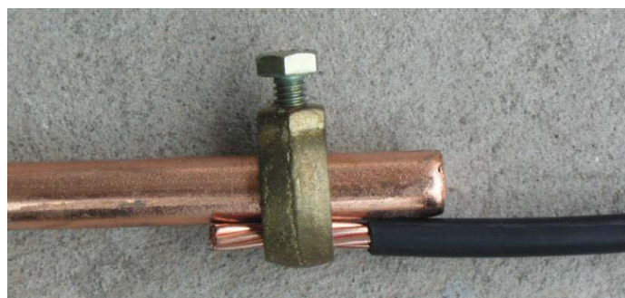
รูปที่ 10 การต่อสายต่อหลักดินเข้ากับดินด้วยแคลมป์
