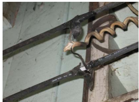
รูปที่ 7 ตัวอย่างจุดต่อสายหลวมจนเกิดความร้อนสูง
